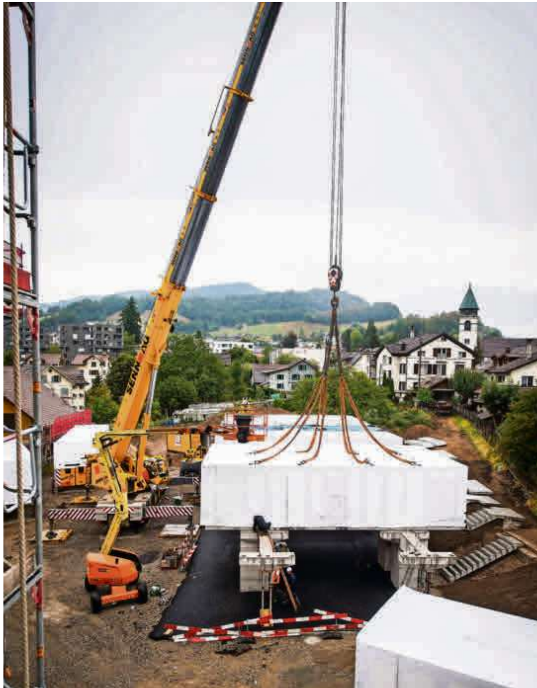
Zwölf Baumodule werden aus Katalonien angeliefert und in Wald dann zusammengesetzt. Foto: Seraina Boner
