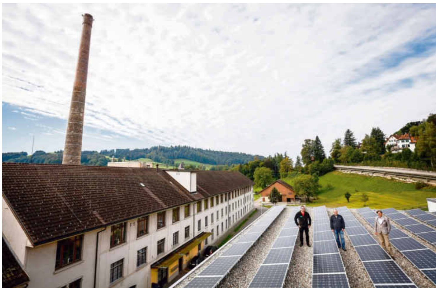
Die Bleiche Wald hat zusammen mit dem EW Wald die bisher grösste Photovoltaikanlage in der Gemeinde realisiert. Bild: Nicolas Zorvi
