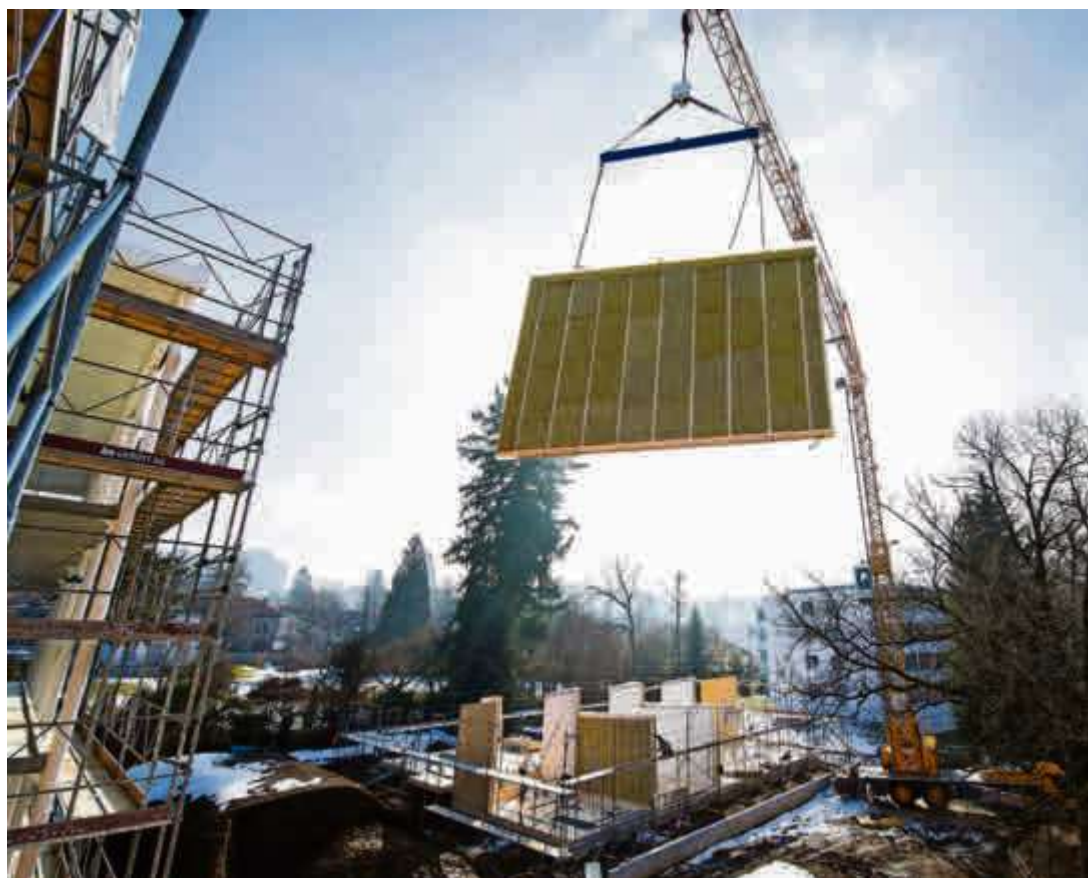
100 Kubikmeter Holz für ein Haus: In drei Tagen ist der Rohbau im Claridapark fertig.
